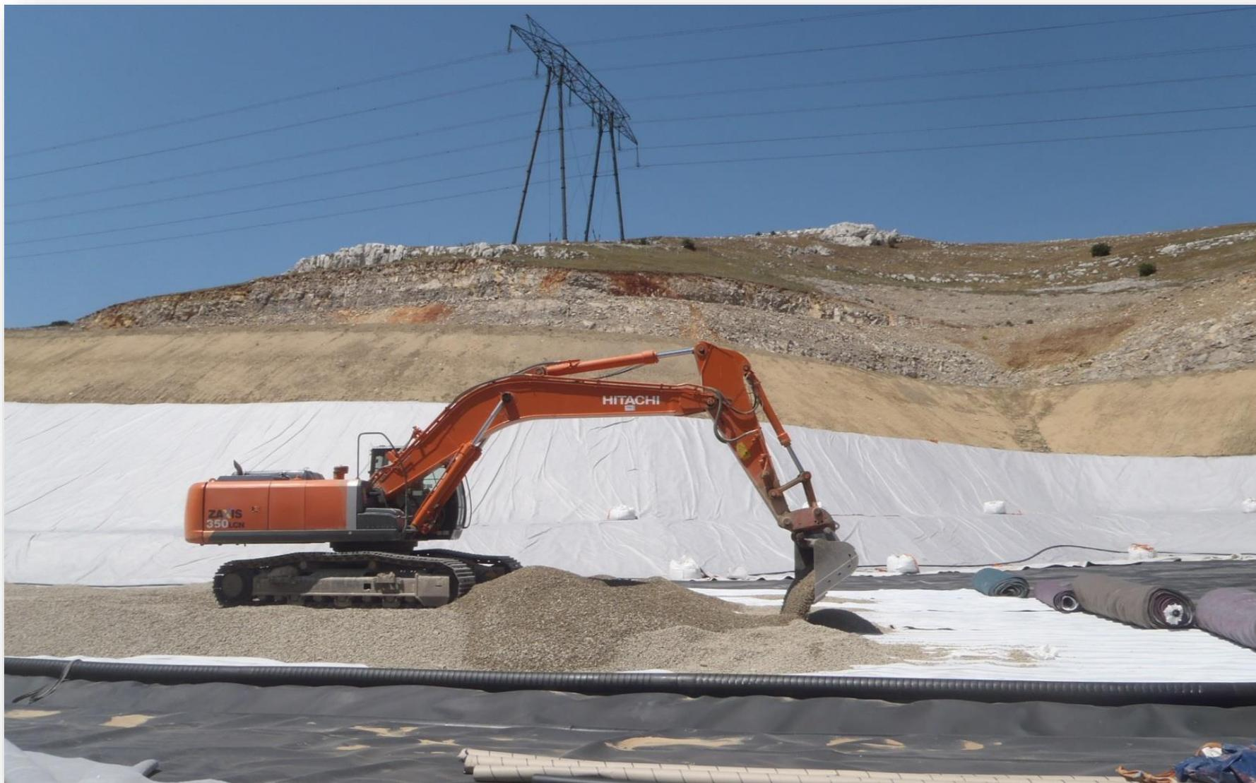
Mise en œuvre du géocomposite de drainage et du gravier drainant
