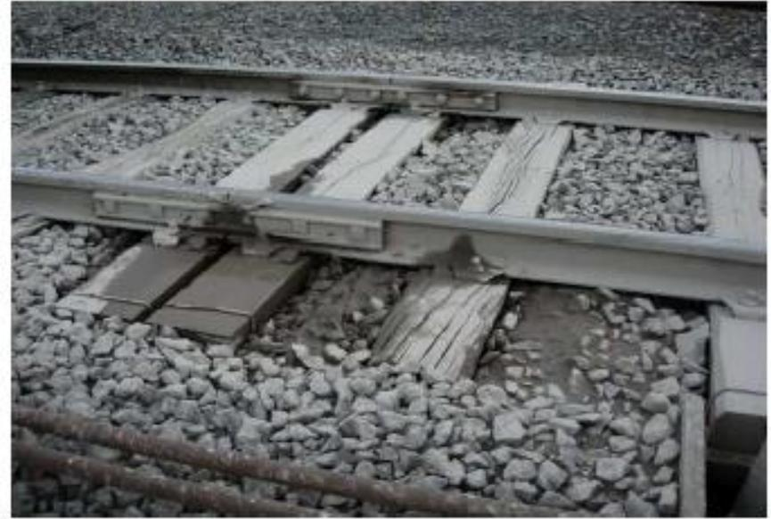
Le défaut d'assise entraîne un battement des traverses et la remontée par pompage des éléments fins du sol:
